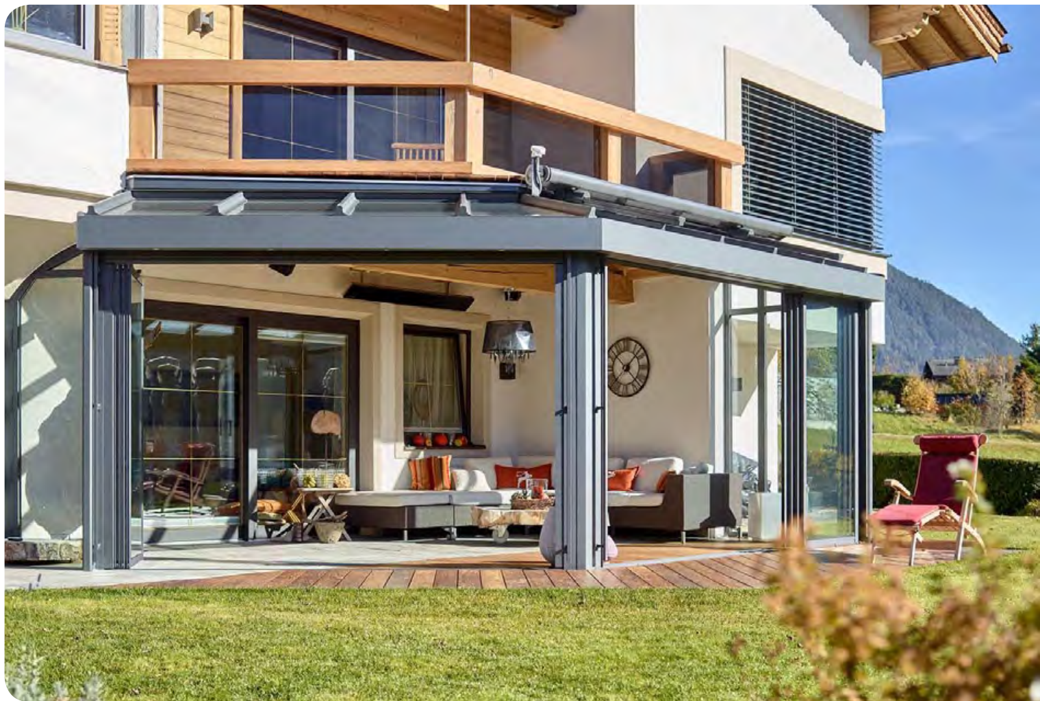
Installazione con pergola, Achenkirch / Tyrol · Austria
